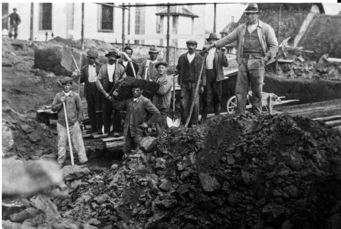
Ouvriers sur le chantier de la nouvelle laiterie, en 1937
